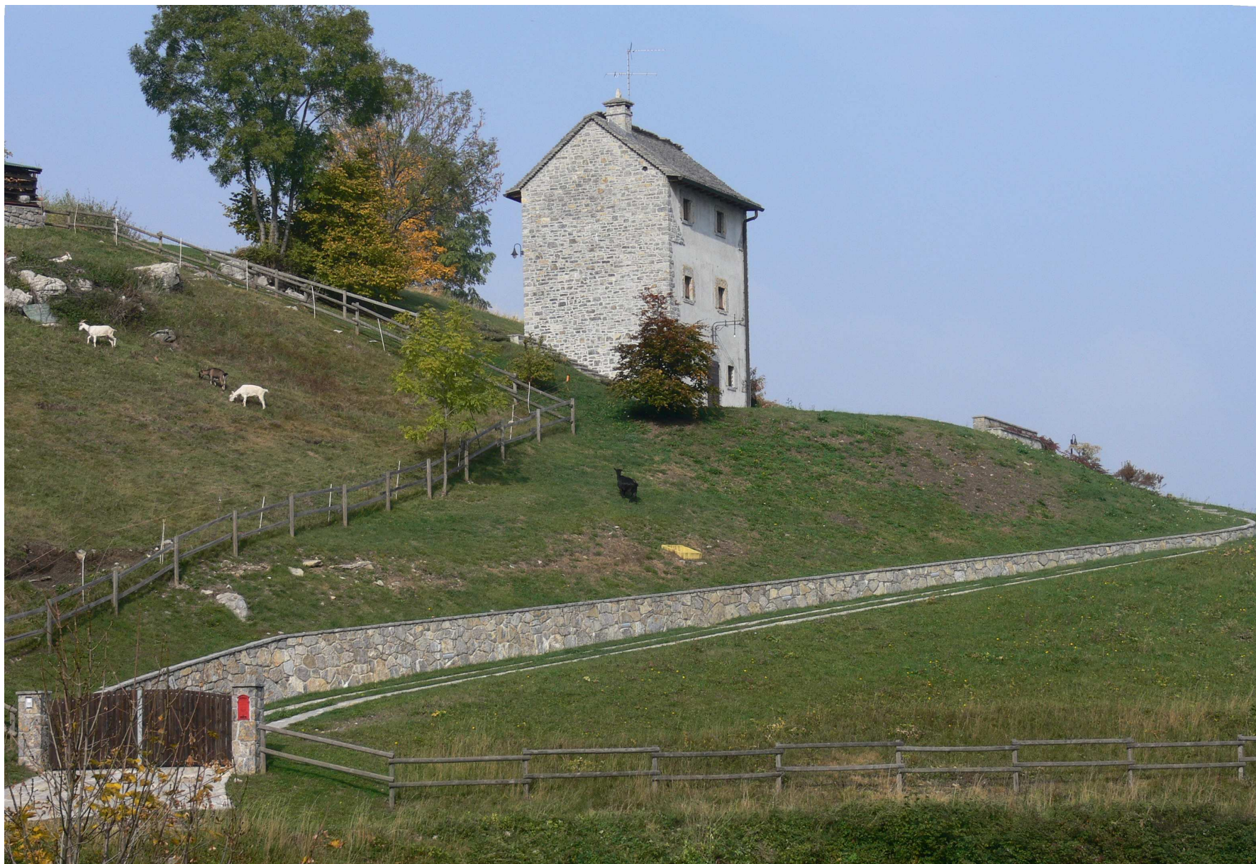
1 bis – Un particolare della visuale paesistica della foto 1 in cui si apprezza il valore e l'importanza delle architetture tradizionali. Un intervento di recupero e sistemazione che rispetta la tipologia edilizia tradizionale apporta un valore aggiunto molto importante al paesaggio e come tale rappresenta un beneficio per tutta la comunità.
