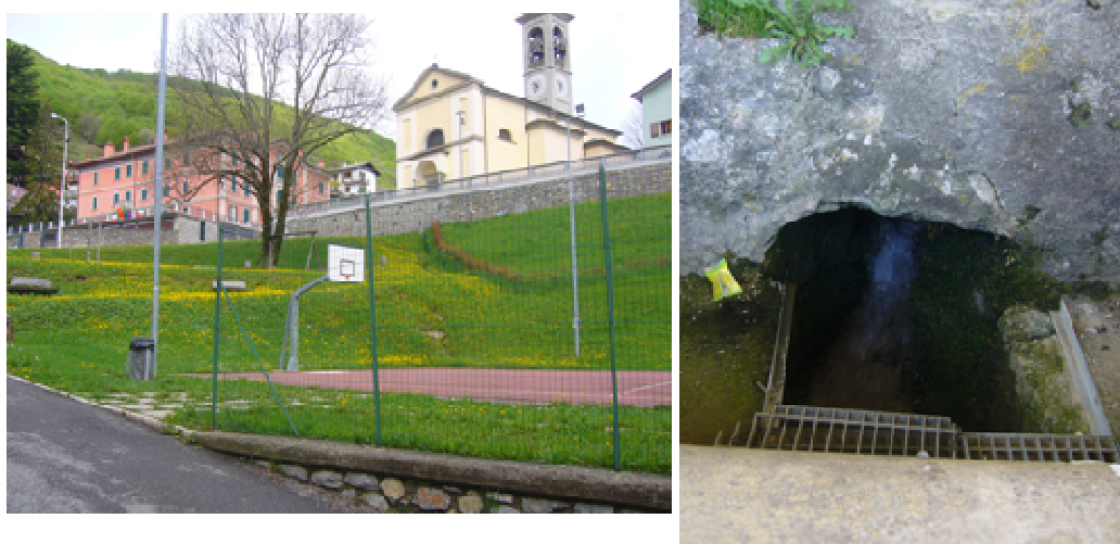
Fig. 4: tratto tombinato nei pressi del campo polisportivo; emergenza del torrente Valle Casino presso il lavatoio.
