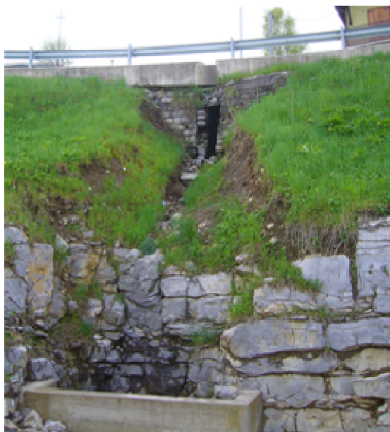
Fig. 3: breve tratto tombinato a ridosso di alcune abitazioni al di sotto della S.P. n°16.
