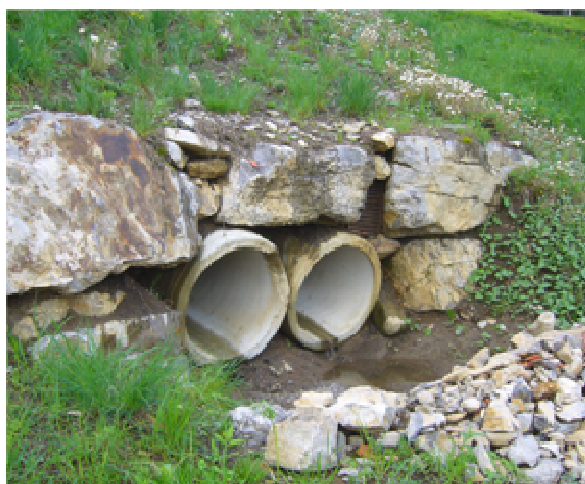
Fig. 3: breve tratto tombinato a ridosso di alcune abitazioni al di sotto della S.P. n°16.
